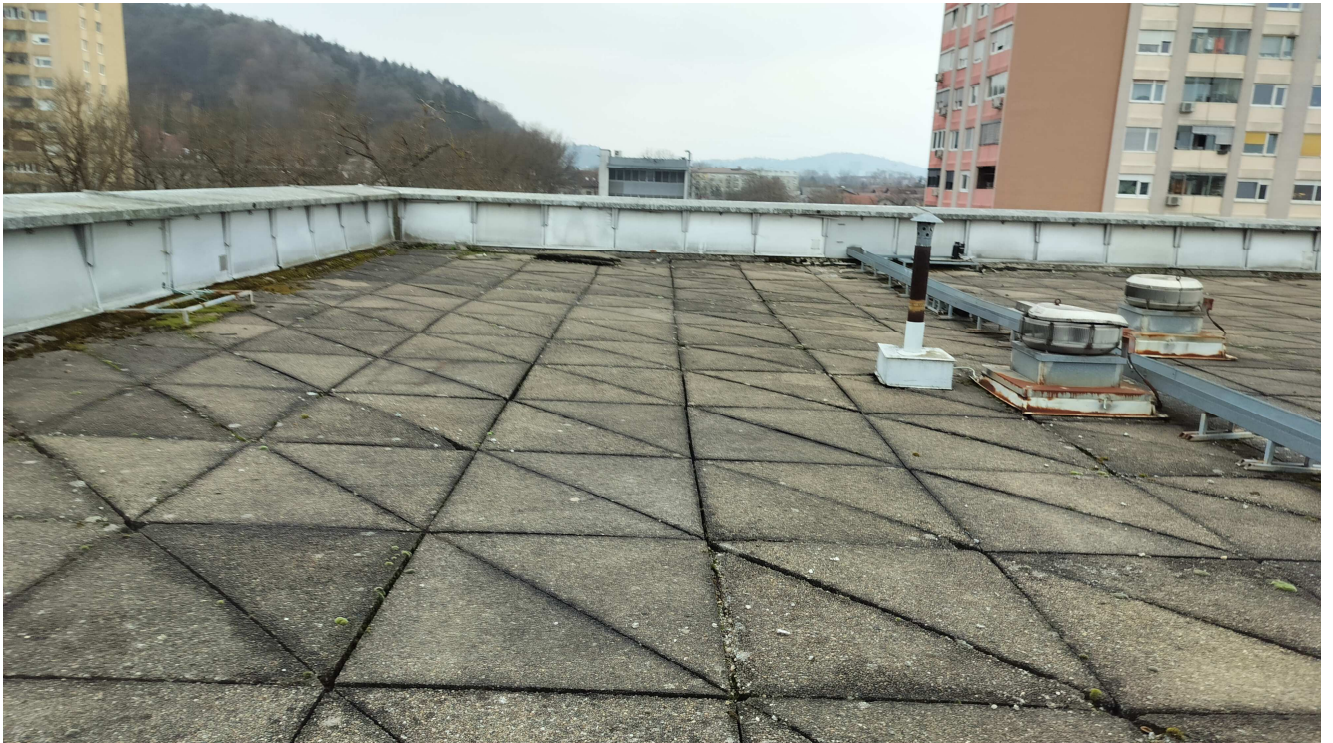
FOTOGRAFIJA št. 10.: Pogled iz južnega dela stavbe - Strehe (tloris 2. nadstropja – št. risbe 05) v smeri vzhod – zahod.
