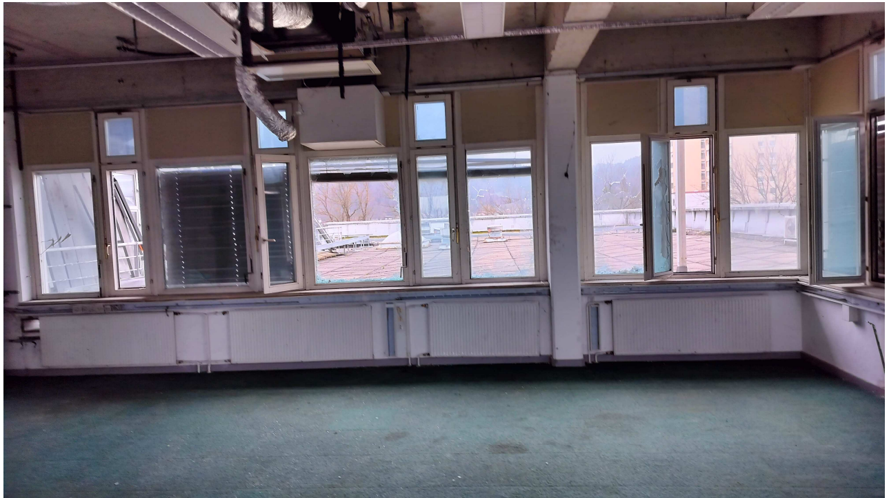
FOTOGRAFIJA št. 12.: Pogled iz sredine prostora Jedilnica 1 (tloris 2. nadstropja – št. risbe 05) v smeri sever – jug na Pokrito teraso 1 in Strebo skozi okna Jedilnice 1.
