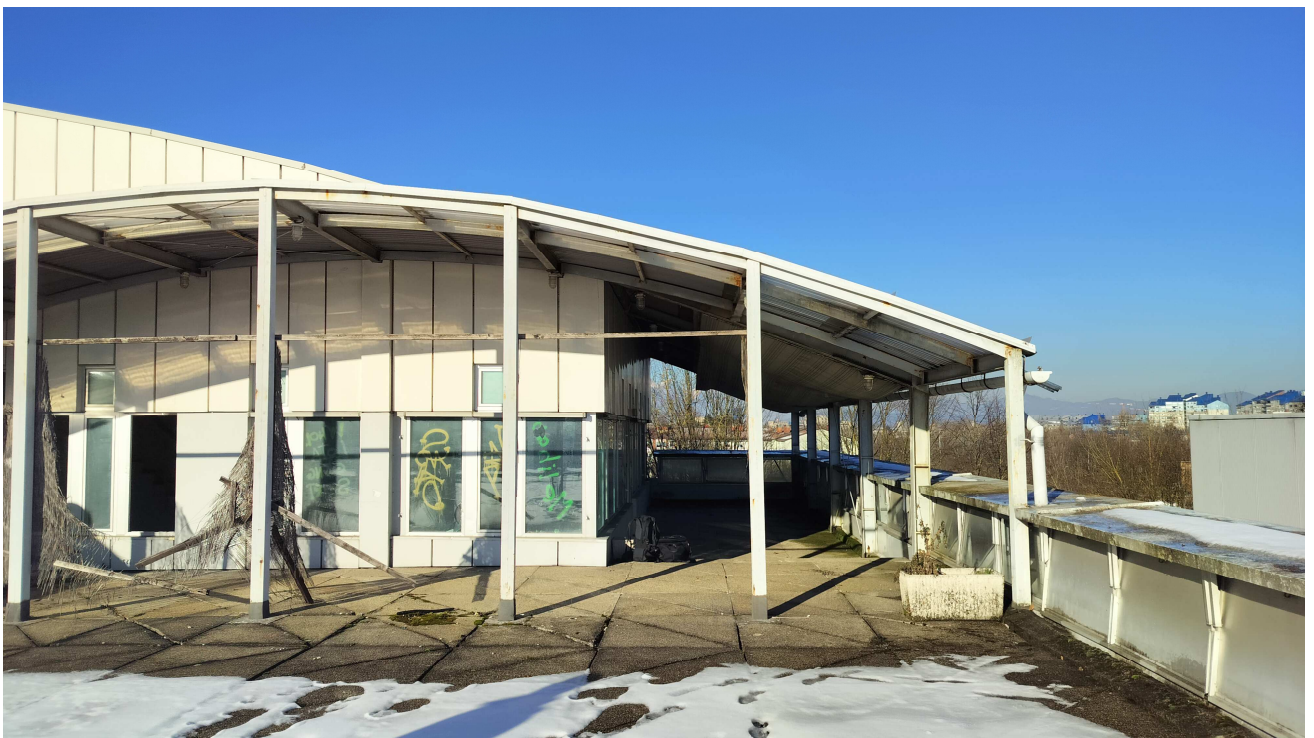
FOTOGRAFIJA št. 9.: Pogled iz Strebe (tloris 2. nadstropja – št. risbe 05) v smeri jug – sever na Pokrito teraso 2.
