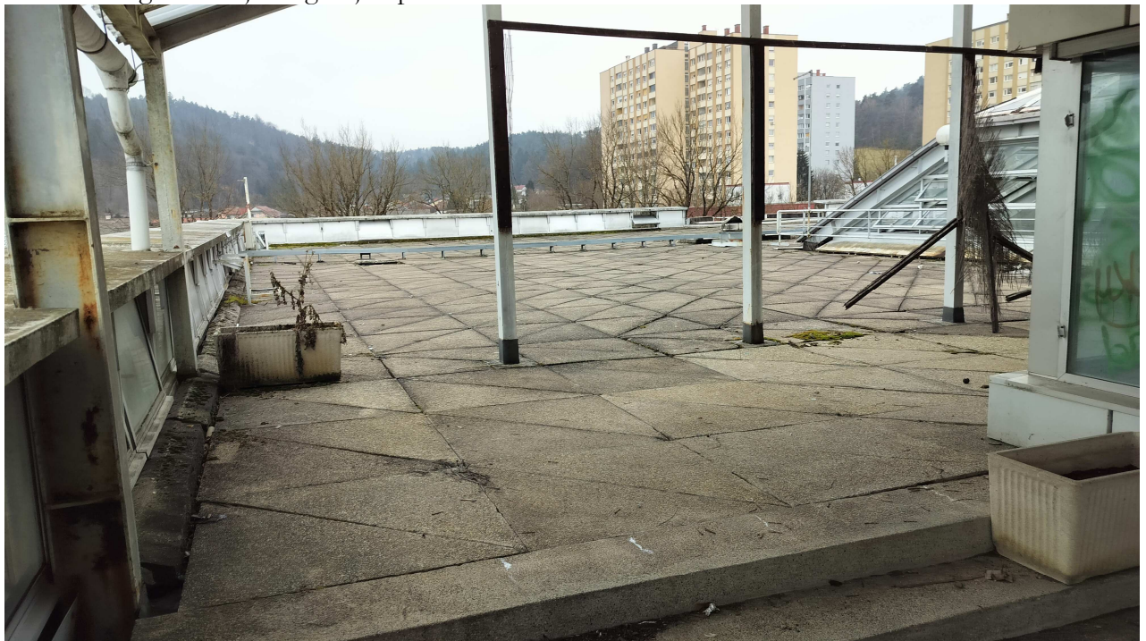
FOTOGRAFIJA št. 7.: Pogled iz Pokrite terase 2 (tloris 2. nadstropja – št. risbe 05) v smeri sever – jug. Na skrajni desni strani fotografije je Jedilnica 2. V osrednjem delu fotografij je na začetku še Pokrita terasa 2 (do kovinskih stebričkov strehe), nato pa je vidna Streha oziroma odprta terasa tlakovana s pobodnimi betonskimi tlakovci..
