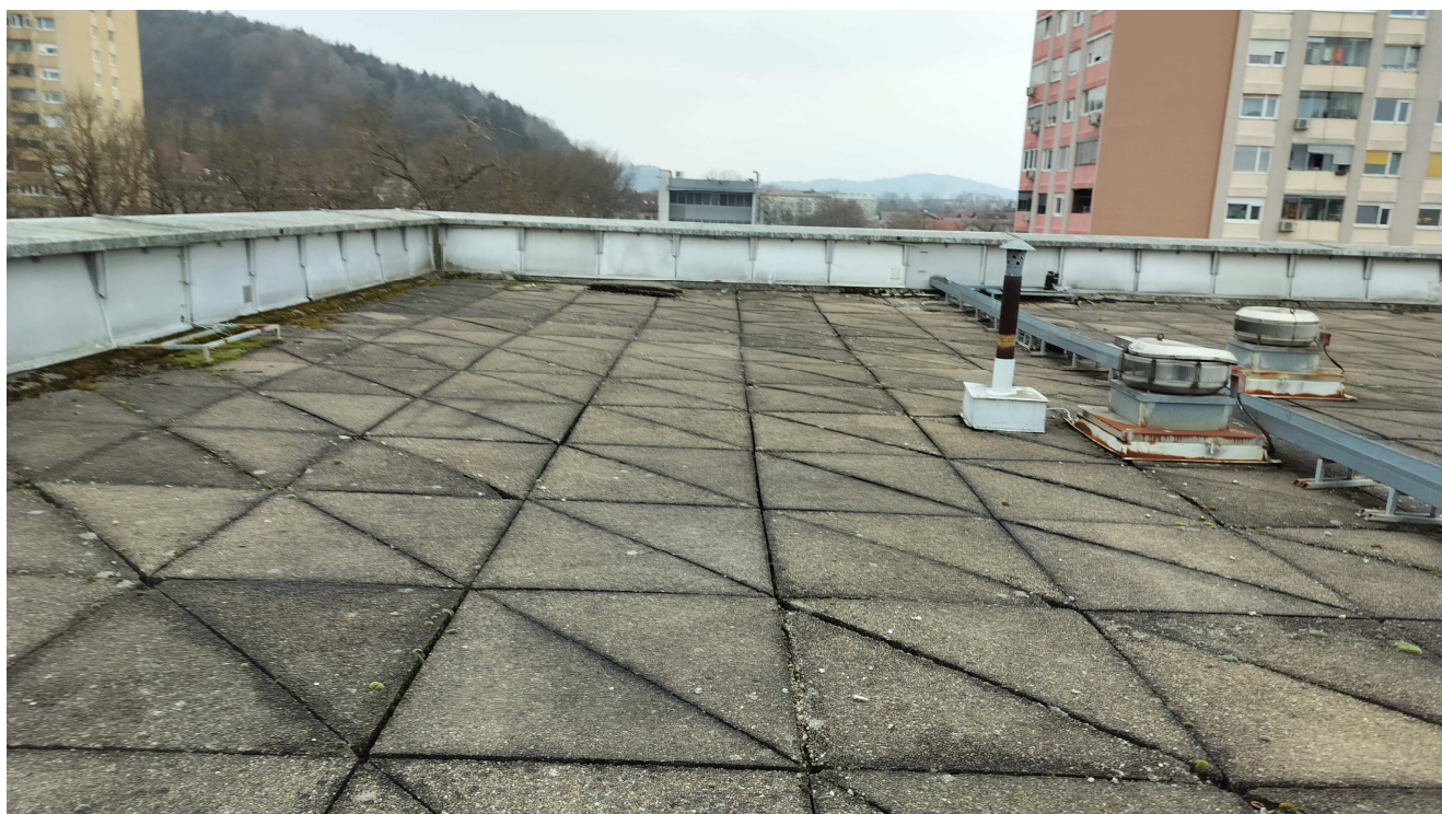
FOTOGRAFIJA št. 10.: Pogled iz južnega dela stavbe - Strehe (tloris 2. nadstropja – št. risbe 05) v smeri vzhod – zahod.
