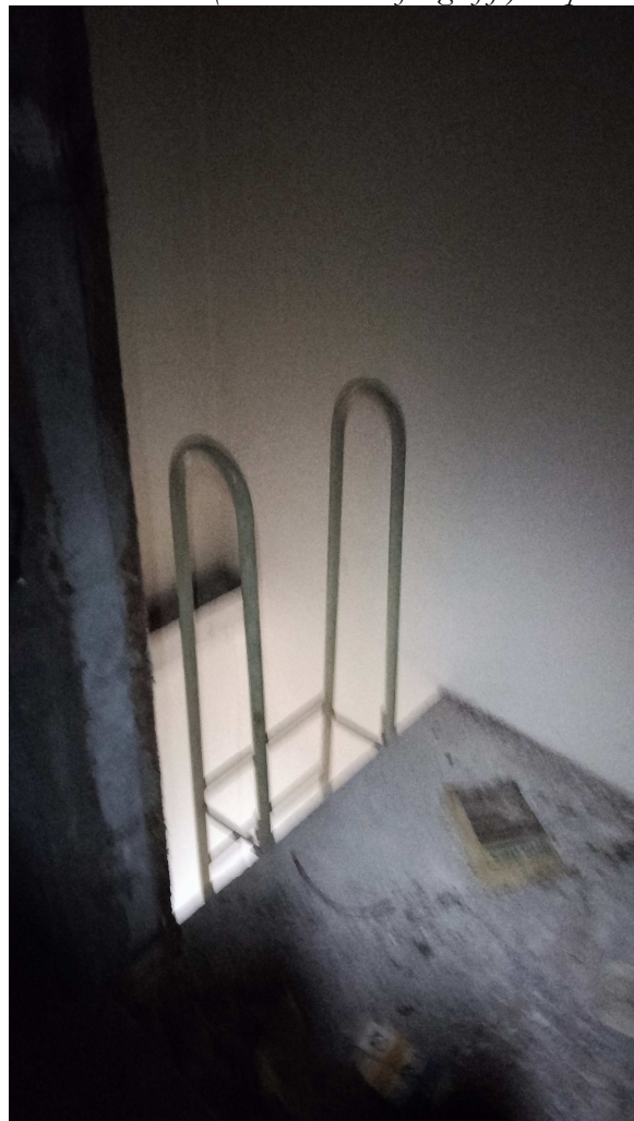
FOTOGRAFIJA št. 5.: Pogled iz podstrešja etažo višje, na vgrajene kovinske lestve in podest podstrešja na katerega se pride iz lestev. Na tem podstrešju so tudi kovinske naprave za prezračevanje.
