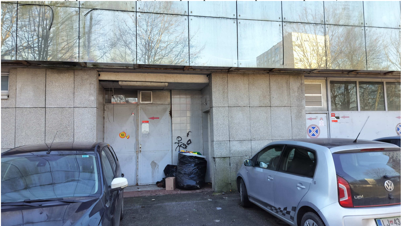
FOTOGRAFIJA št. 3.: Pogled iz asfaltne ceste (parcela št. 200/106 k.o. 1732 Štepanja vas) na del severnega pročelja ob severozahodnem vogalu obravnavane stavbe na desni.. Na desni strani fotografije so vidna dvojna kovinska vrata (ena običajna in ena dvignjena), ki vodijo v Strojnico 1 (risba 02). Levo od sredine fotografije je v površino PID nezajet dovozni prostor (dovozna rampa, ki ni dvignjena). Desno od tega prostora je manjša sbramba s prikazano površino. Iz dovoznega prostora se vstopi v Strojnico 2 (risba št. 02), ki je dejansko hodnik. Blizu je dvigalo s katerim so dovažali razen material in hrano ter odvažali smeti. Verjetno je bil to glavni dovoz za obravnavano stavbo.
