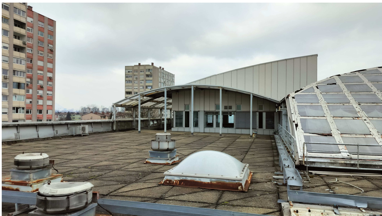
FOTOGRAFIJA št. 11.: Pogled iz stojišča nekoliko naprej in nato pravokotno desno iz južnega dela stavbe - Strehe (tloris 2. nadstropja – št. risbe 05) v smeri jug – sever na Pokrito teraso 1.
