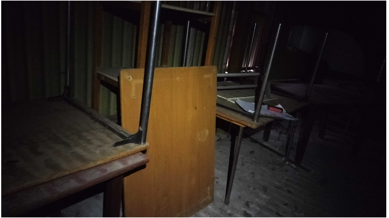
FOTOGRAFIJA št. 6.: Pogled na del podstrešja nad Jedilnico 2 in Recepcijo (tloris 2. nadstropja – št. risbe 05). Na podstrešje (tloris podstrešja – risba št. 06) se pride po betonskih stopnicah vidnih iz risbe št. 06. Na podstrešju je kar nekaj raznega pohištva, kot je razvidno iz fotografije.
