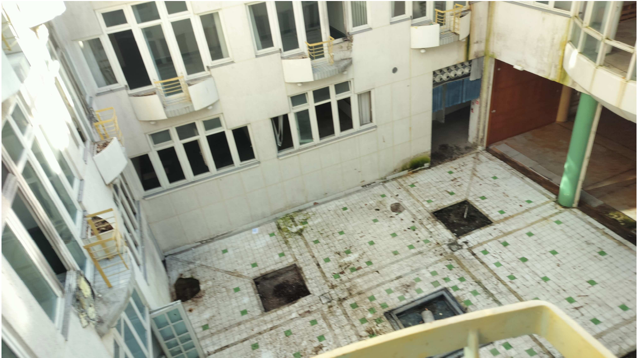
FOTOGRAFIJA št. 2.: Pogled iz balkona na pokrito notranje dvorišče nad Atrijem. Vidnih je nekaj balkonov, ki so različno uničeni (levo in na sredini fotografije zgoraj). Spodaj je viden Atrij in na desni strani še velika Dvorana, nad njo zaprt balkon Vhodnega prostora (risba 3).
