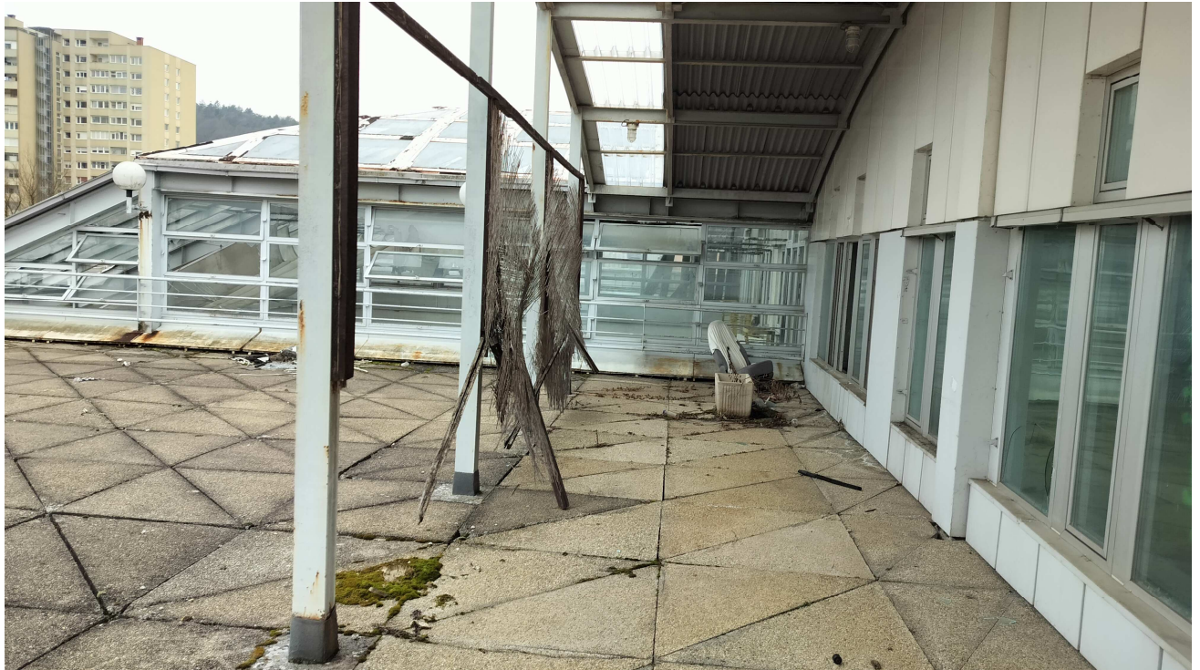
FOTOGRAFIJA št. 8: Pogled iz prejšnjega stojišča nekoliko naprej in nato desno v smeri vzhod - zahod. Desno od kovinskih stebričkov strebe je Pokrita terasa 2, levo pa Streba. Oboje je dejansko odprta terasa, tlakovana z betonskimi pobodnimi ploščami.
